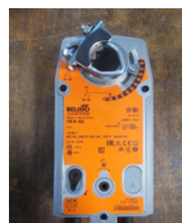
Actionneur non alimenté registre ouvert
