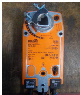
Actionneur non alimenté registre ouvert
