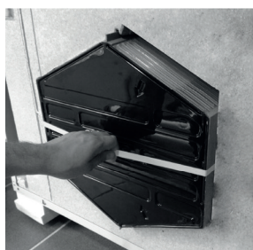
1 – Sortir l'échangeur en tirant sur la sangle. Faire attention à l'orientation de l'échangeur dans la VMC.
