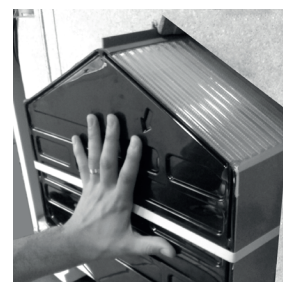
3 – Remettre l'échangeur en place en respectant le sens de l'air.
